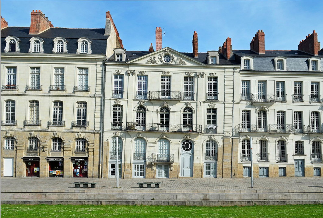
Bâtiment de l'Île Feydeau, Nantes foundation movement
