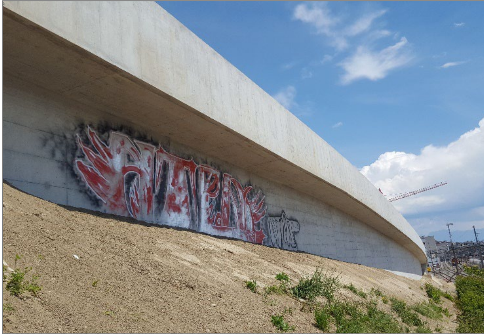
Liaison Ouest, Plateforme 10, Lausanne retaining wall
