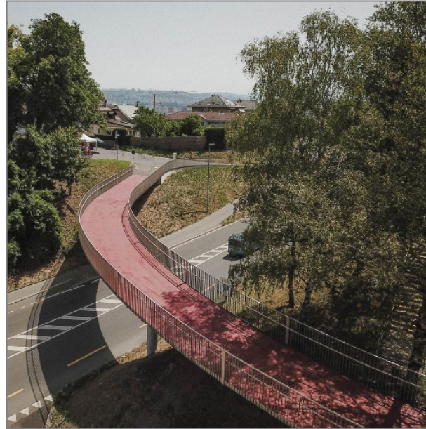
Route de la Pierre, Ecublens footbridge
