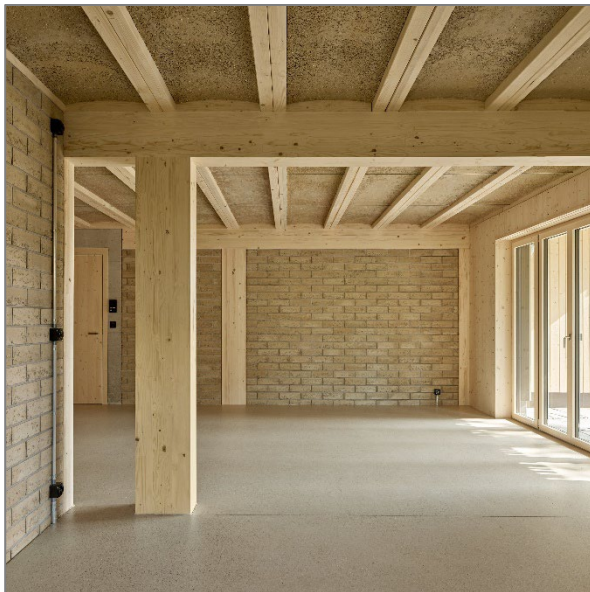
Earth bricks, earth and timber slabs (Rematter®) Maison intergénérationnelle, Altendorf Jomini Zimmermann architectes, 2024
